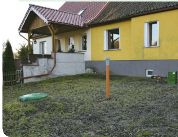
Przydomowa oczyszczalnia ścieków
